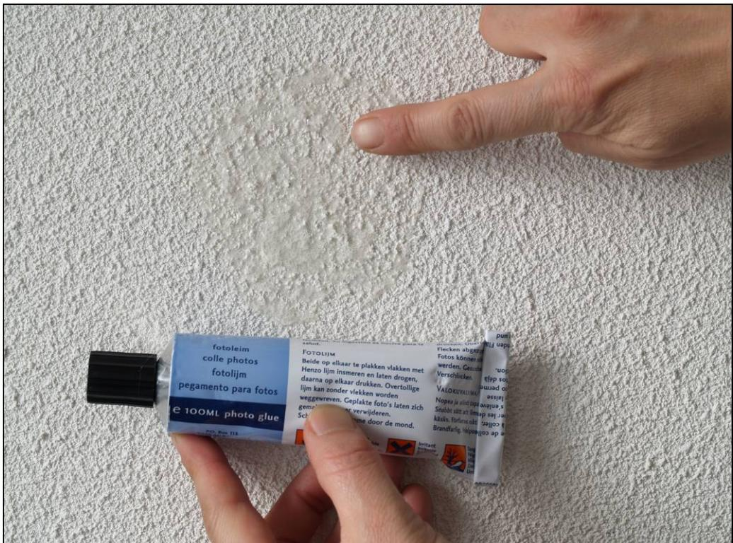
図 8.3 写直接着剤の適用：接着剤を壁につけてください。センサーを設置する前に、設置部分を乾かしてください。
