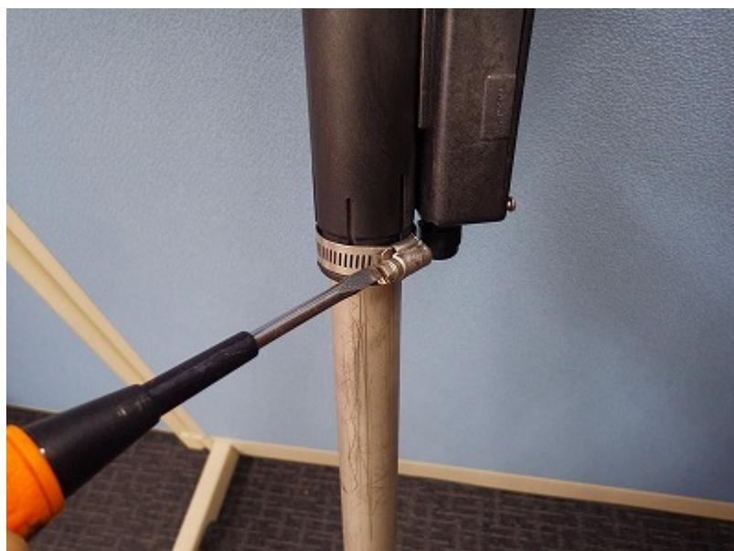
方位(配線ボックスの向き)を決めたら、写真のホースクランプをマイナスドライバ等で締め付けて下さい。締め付け後、取付部分を持って、上下にずれない事を良く確認し、動く場合は増し締めして下さい。
